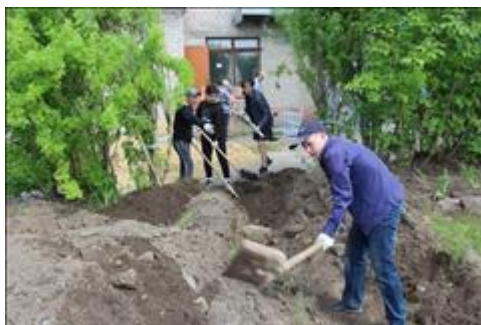
Выемка грунта для обустройства дорожки В дальнейшем здесь будут обустроены дорожки с использованием песка, щебня и декоративного камня, адаптированные для передвижения людей на инвалидных колясках
